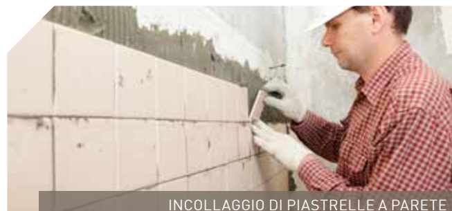
INCOLLAGGIO DI PIASTRELLE A PARETE
