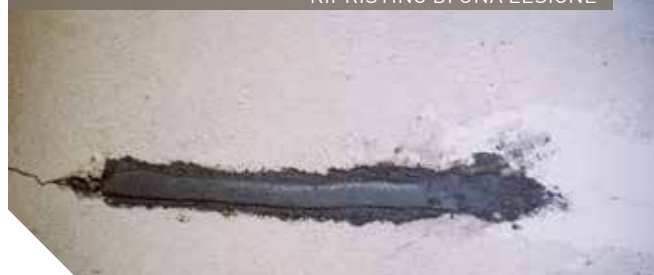
RIPRISTINO DI UNA LESIONE
