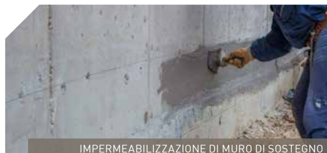
IMPERMEABILIZZAZIONE DI MURO DI SOSTEGNO
