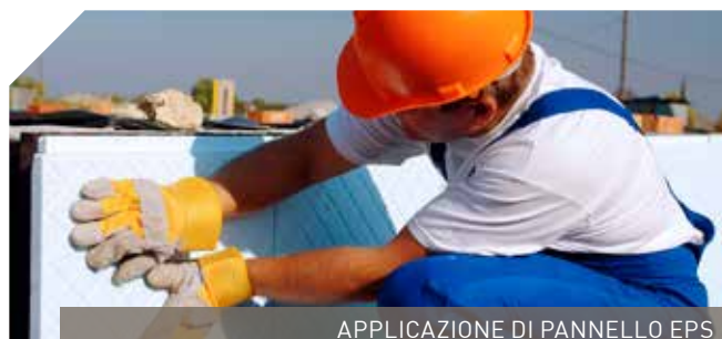
APPLICAZIONE DI PANNELLO EPS
